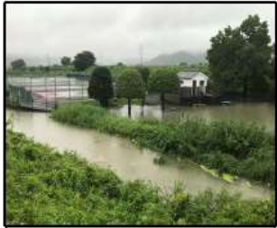
テニスコート駐車場は浸水
