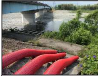
適度な重量によりホースの暴れもない。⇒稼働時に再確認必要
