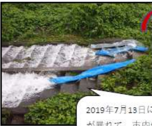
ビニールホースで折れ曲がると排水ポンプの能力が発揮できない
