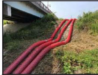
サクシヨンホースは耐圧・耐熱性と屈曲性がありながら、ホースの扁平が少ないため、ポンプ能力を低下させにくい
