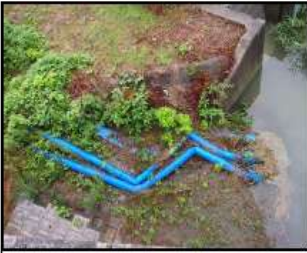
ビニールホースで折れ曲がると排水ポンプの能力が発揮できない
